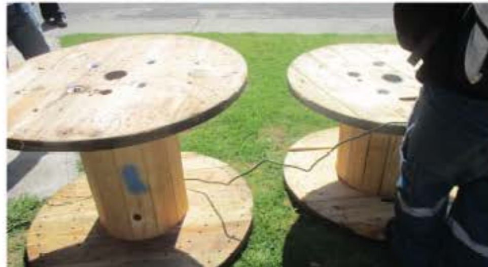
2: Perforación de carretes para realizar orificios y anclarlos con grapas de varillas 3/8" al sitio.
