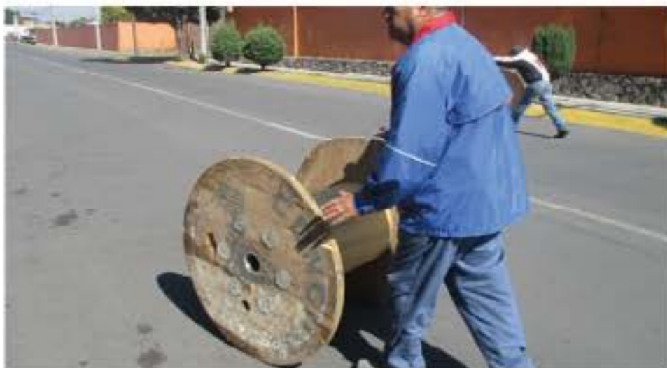
1: Suministro y transporte de carretes al sitio.
