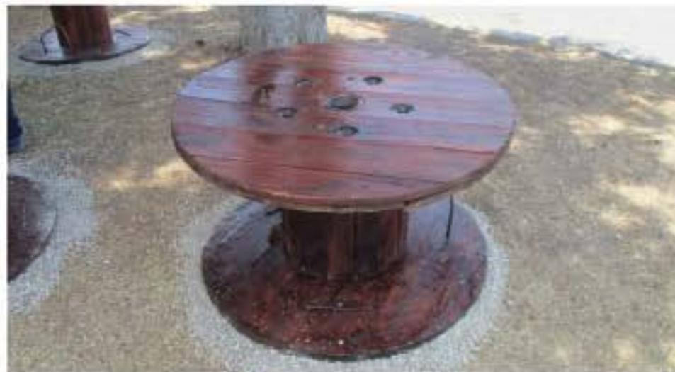
4: Colocación de gravilla gris, 6-12mm, alrededor de la intervención en carretes
